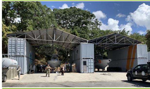
Figure 22. ARD Flotilla Hangar, Las Dragas
